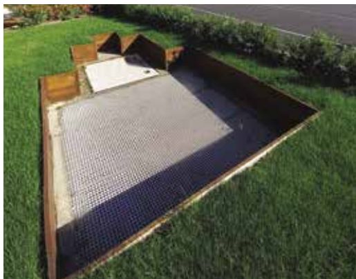
Cuve de récupération des eaux pluviales sur l'île de Puteaux
